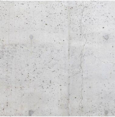
STĚNA Přiznaná železobetonová nosná stěna Opatřeno penetračním nátěrem
