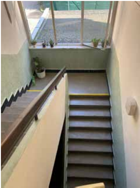
02. schodiště patrová budova
