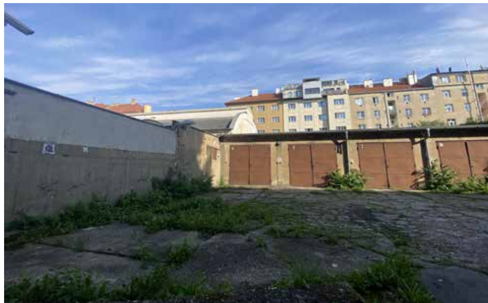
06 samostatné garáže vně budovy, jihovýchod
