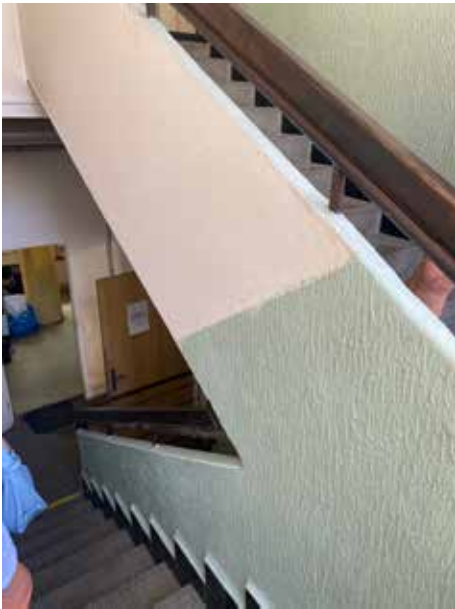
03. schodiště patrová budova
