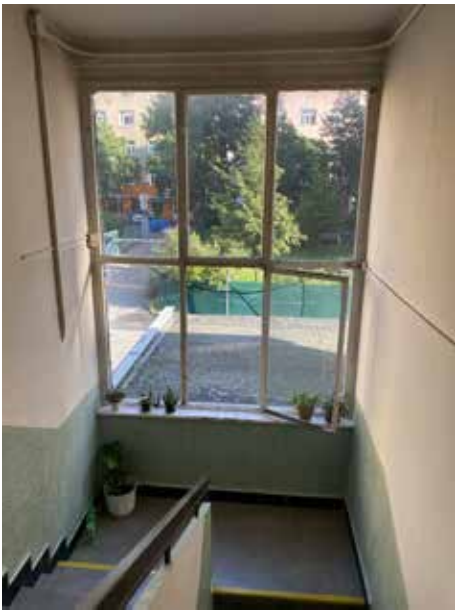
01. schodiště patrová budova
