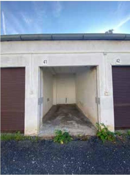
14. venkovní garáže, východ
