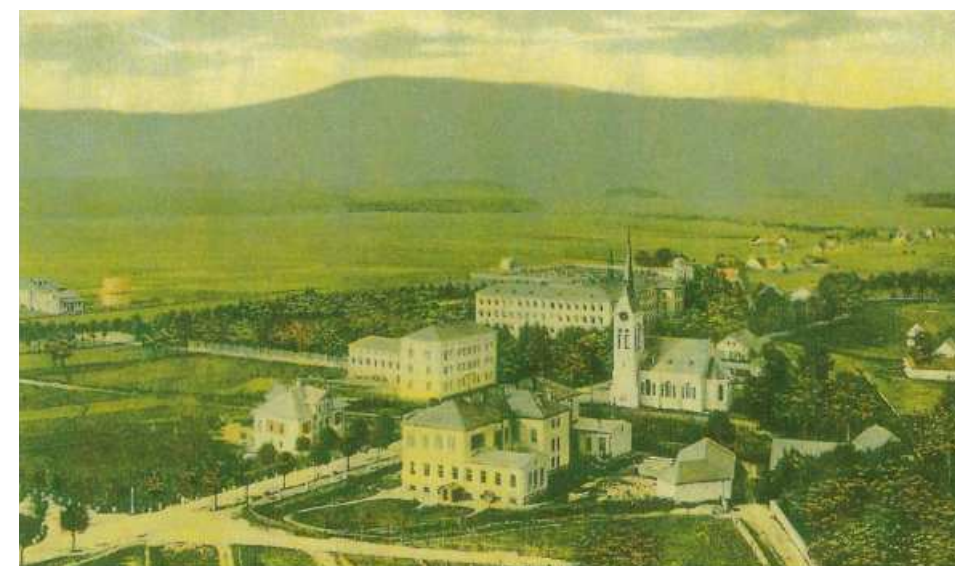
Částečný pohled na město z věže kostela, vlevo objekt plynárny, kolem roku 1910 (zdroj: archiv Městského muzea a informačního centra Králíky)
