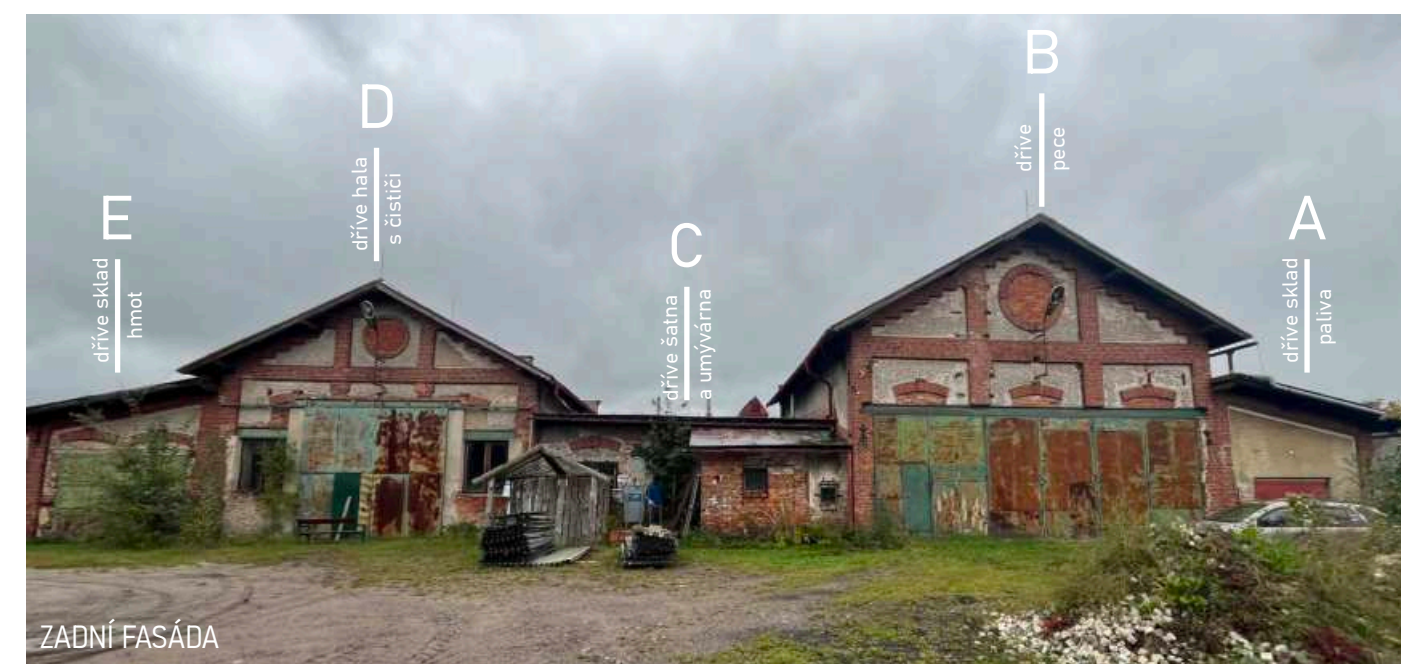
Zádní fasáda poničená nevhodným umístěním plechových vrat (zdroj: archiv autora diplomové práce)
