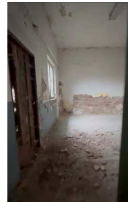
Interiér prostřední části stavby C (zdroj: archiv autora diplomové práce)
