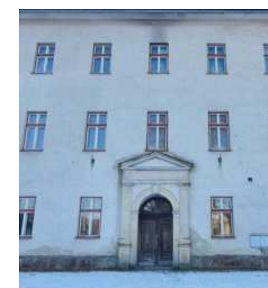
Vstupní portál do budovy (zdroj: https://www.denik.cz/z_domova/z-byvaleho-detskeho-ustavu-v-kralikach-by-mohla-byt-veznice-20160908.html )
