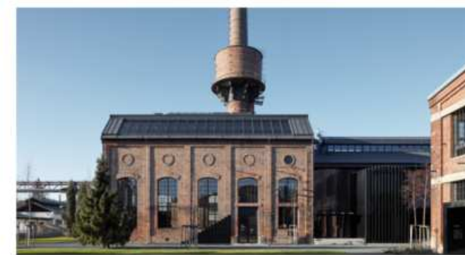
Konverze bývalé Kotelny v Libčicích nad Vltavou
