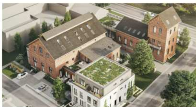
Konverze bývalé plynárny ve městě Nauen (zdroj: https://www.archlab.de/projekte/historisch/leuchtgaswerk-nauen/ )
