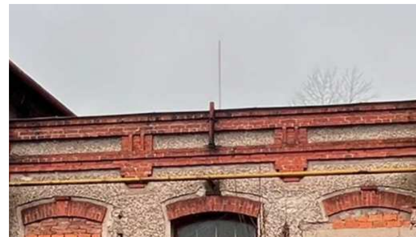
Zachovalá atika (zdroj: archiv autora diplomové práce)
