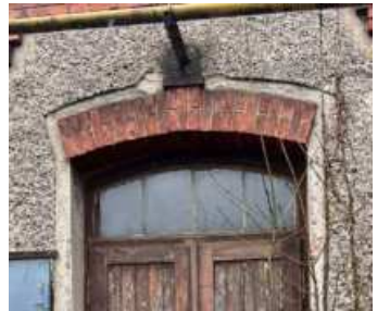
Původní záklenky nad oknem a dveřmi (zdroj: archiv autora diplomové práce)
