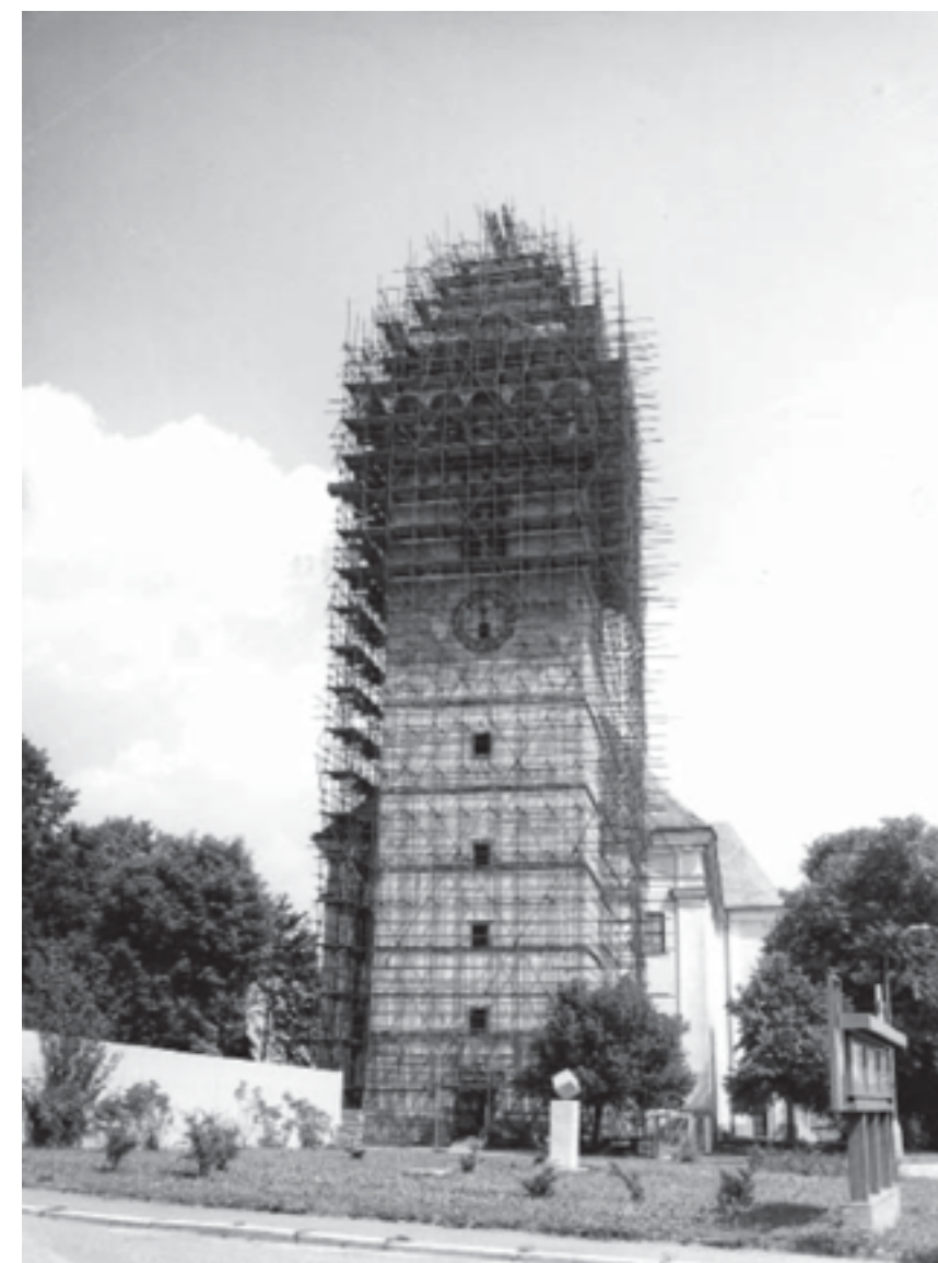
312__oprava kostelní věže, 1987
