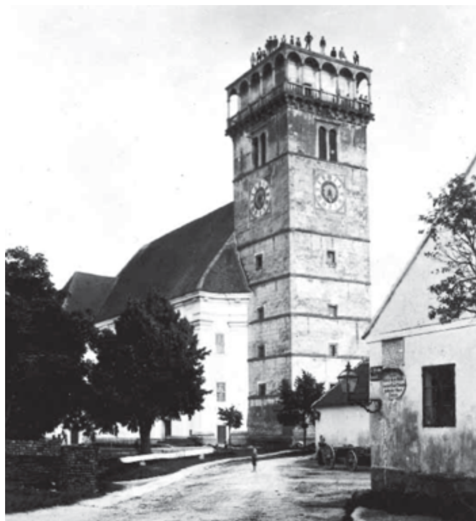
311__rekonstrukce střechy věže, 1910
