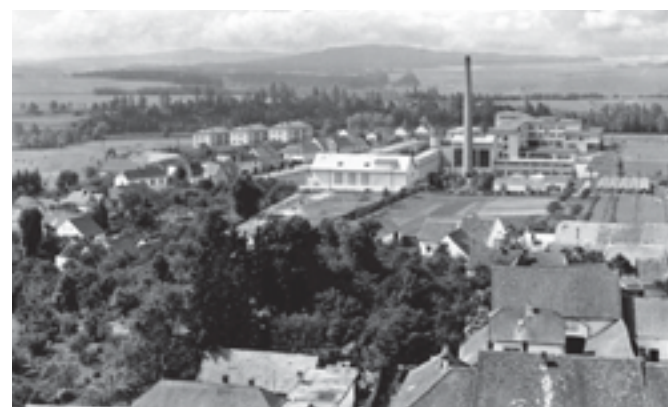
355__areál nemocnice z věže, 1960s
