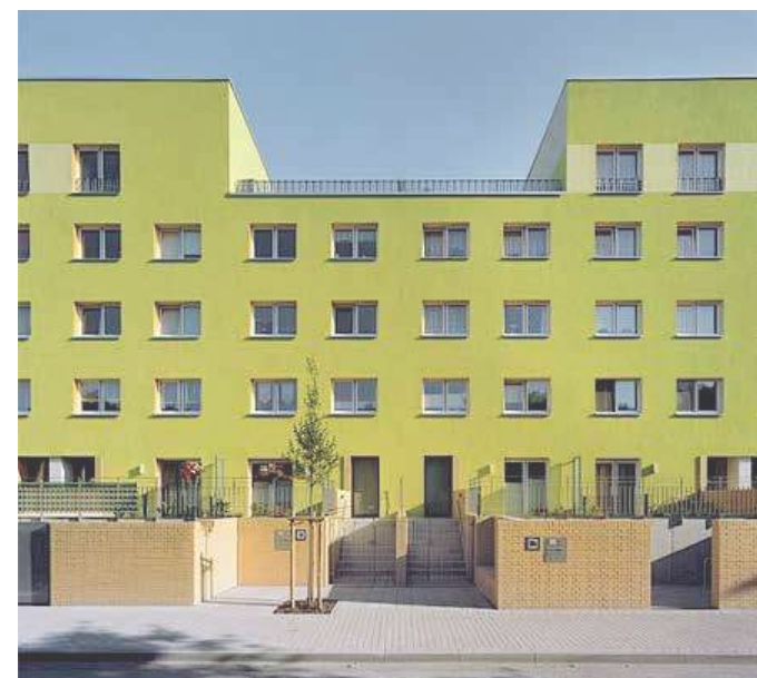
práce se vstupy Haus 08 / Halle-Neustadt, Německo Stefan Forster GmbH / 2010
