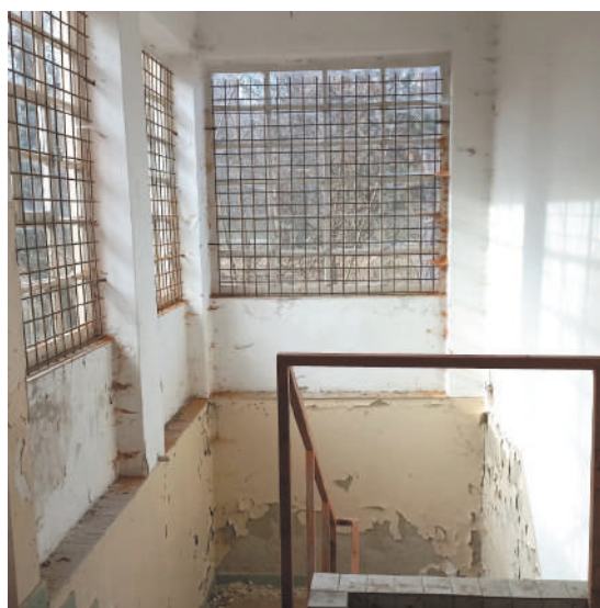
dostavané schodisko na mieste pôvodnej terasy v 60. rokoch
