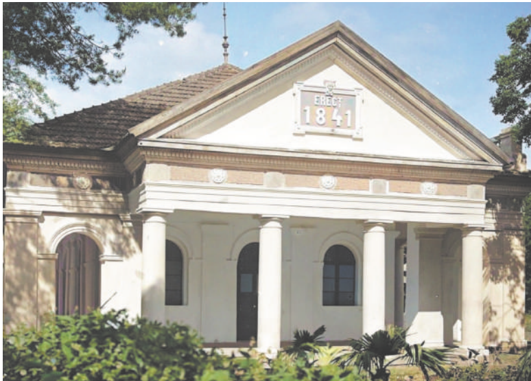
hlavný kúpeľný dom- zľoku
