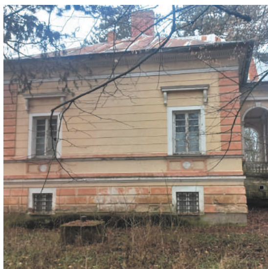
východná fasáda so zrušenou stredovou osou
