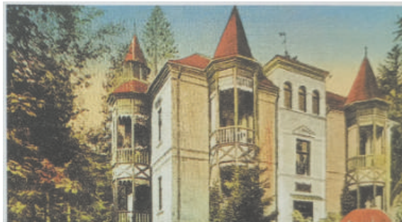
bývalá Františkova vila- Bardejovské kúpele
