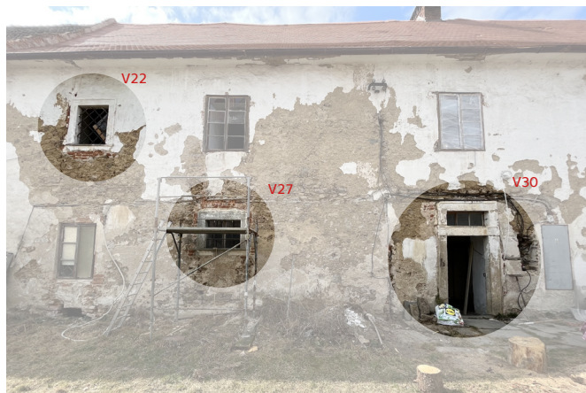
interpretace: kamenná ostění osazená při nedokončené realizaci vrcholného baroka stav k roku 2022 autorská fotodokumentace, archiv Bc. Houdová
