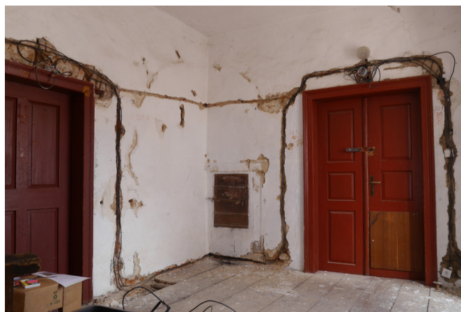
nálezová situace 201A a 201AA - stopa po „kupoli“ topeniště stav k roku 2022 autorská fotodokumentace, archiv Bc. Tomášiková
