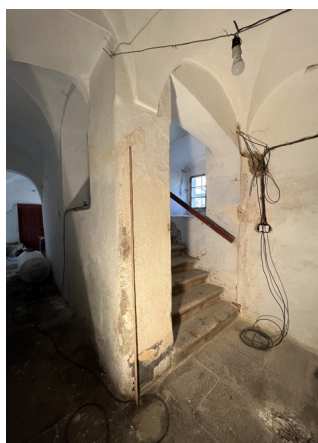
pohled do nástupního prostoru schodiště a chodby 1.07 stav k roku 2022 autorská fotodokumentace, archiv Bc. Houdová pohled do chodby 1.07 z nástupního prostoru schodiště stav k roku 2022 autorská fotodokumentace, archiv Bc. Tomášiková
