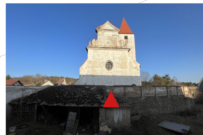
P3 pohled na západní průčelí kostela z patra fary označení polohy portálu stav k roku 2022 autorská fotodokumentace, archiv Bc. Houdová
