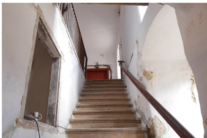
pohled na schodiště z nástupního prostoru stav k roku 2022 autorská fotodokumentace, archiv Bc. Tomášiková
