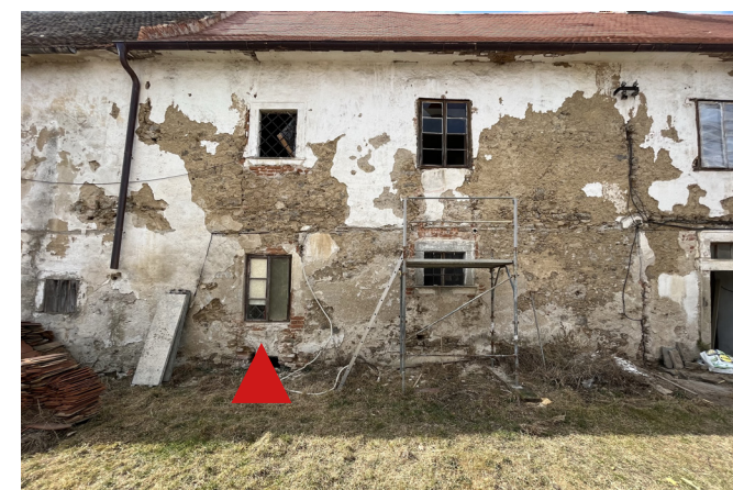
P2 pohled na východní fasádu fary s vyznačením pozice hypotetického vstupu stav k roku 2022 autorská fotodokumentace, archiv Bc. Houdová
