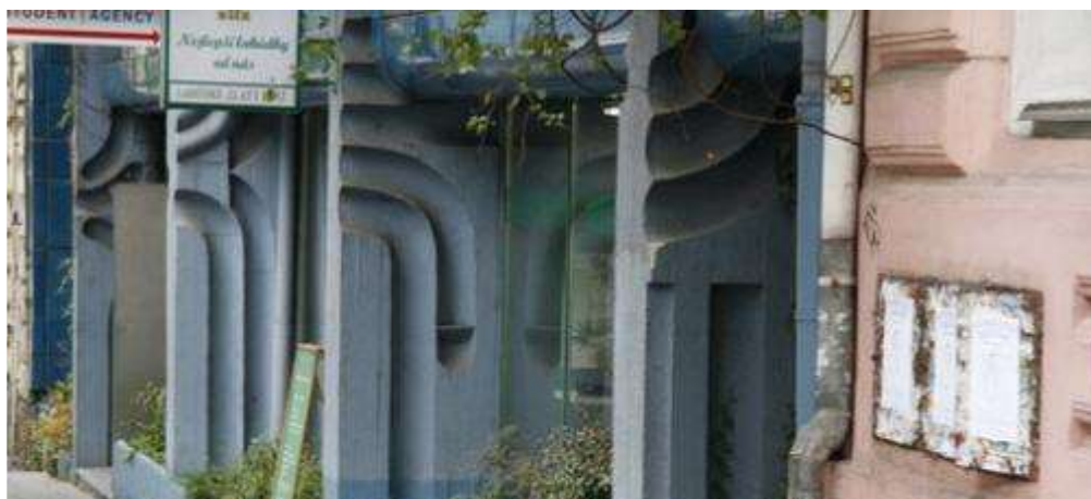
1984, litý beton, na fasádě budově Teplotechny
