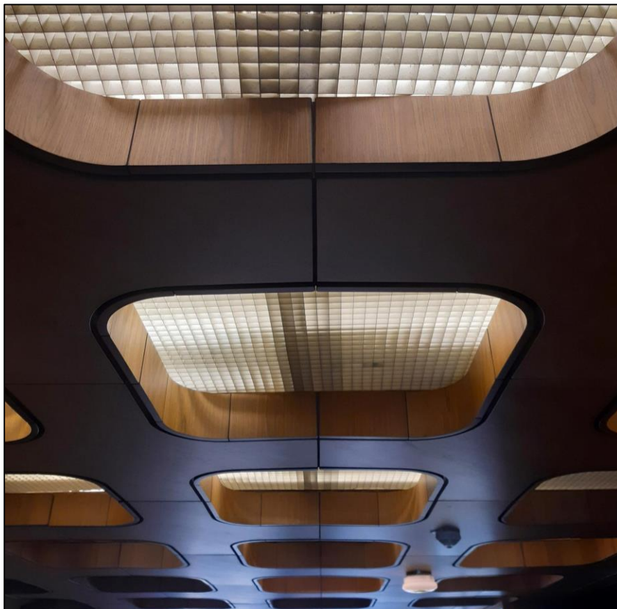
Osvětlení v přízemí a v Café Nona, je řešeno stropními rošty zapuštěnými do dřevěného obkladu
