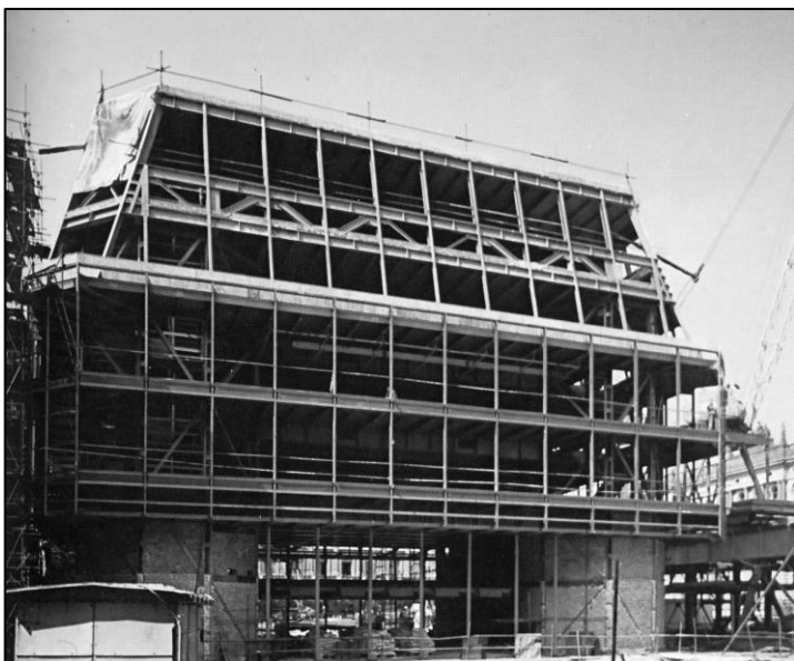
Nosná ocelová konstrukce restaurační budovy, vyrobená ve VŽKG v Ostravě
