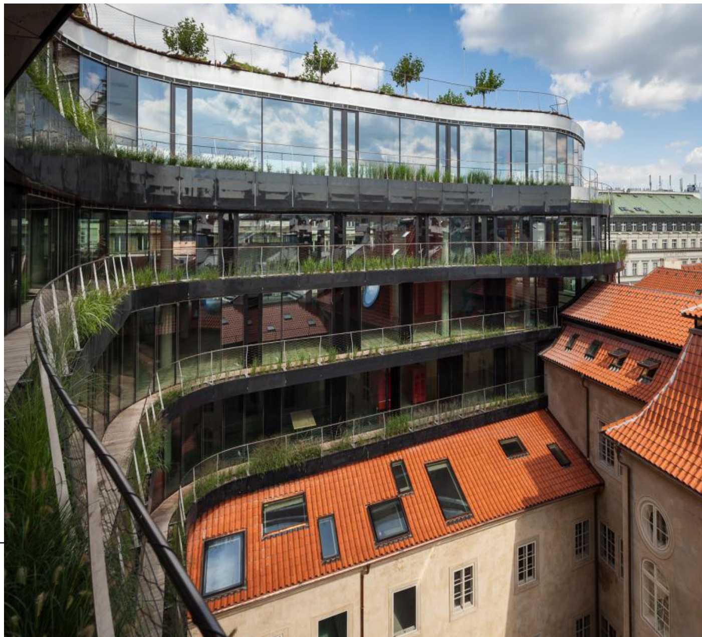
Kontrast dynamické fasády DRNu a střechy z tradičních tašek. (zdroj: www.sebre.cz )
