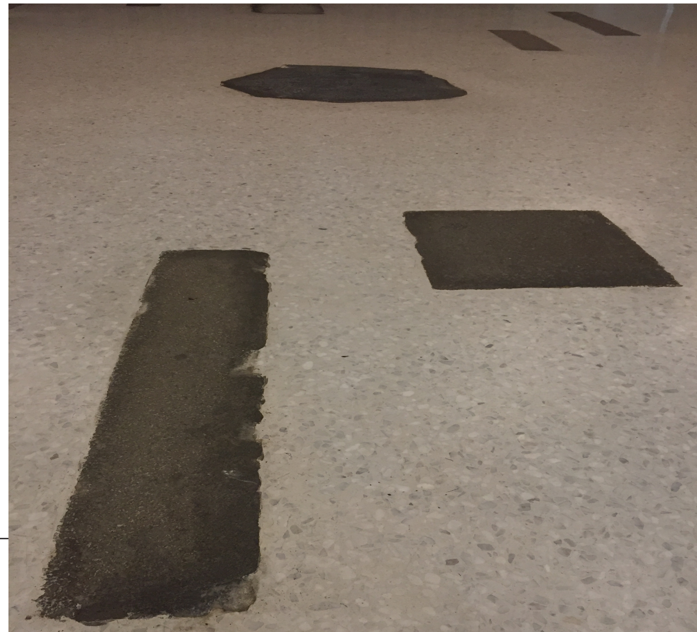
Detail podlahy v přízemí, náznak historie pomocí starých stavebních prvků.
