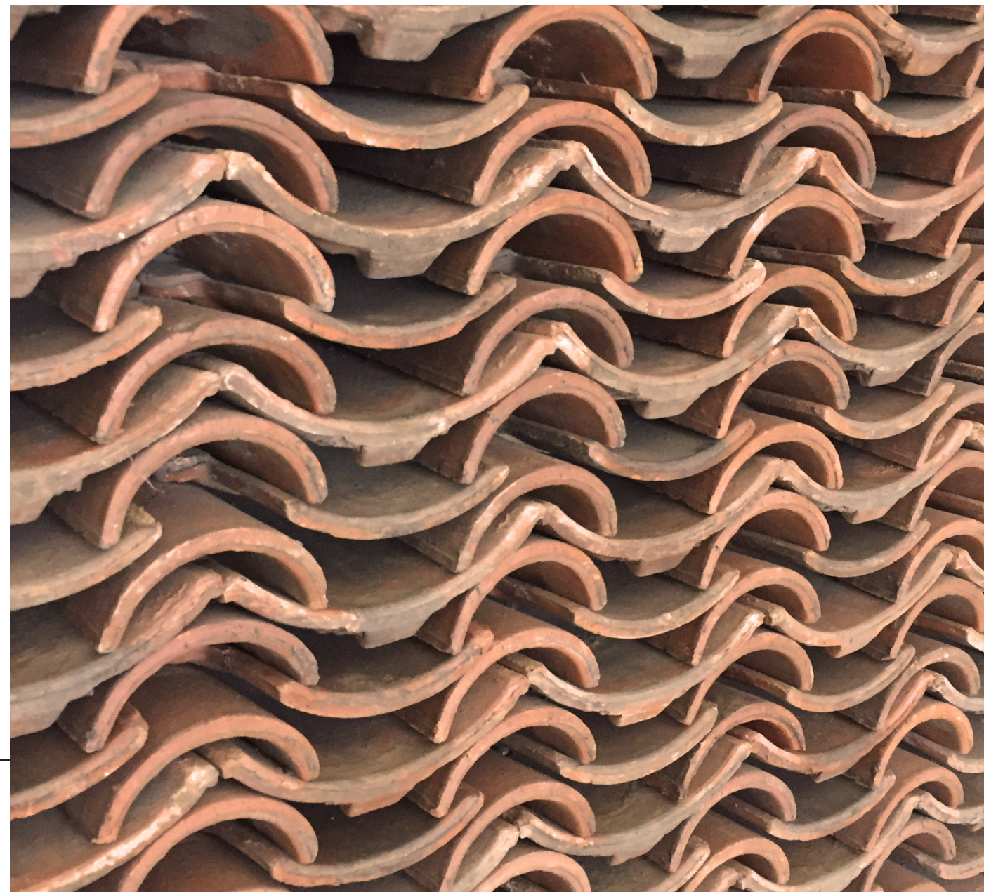
Detail recepční přepážky z recyklovaných starých pálených tašek.
