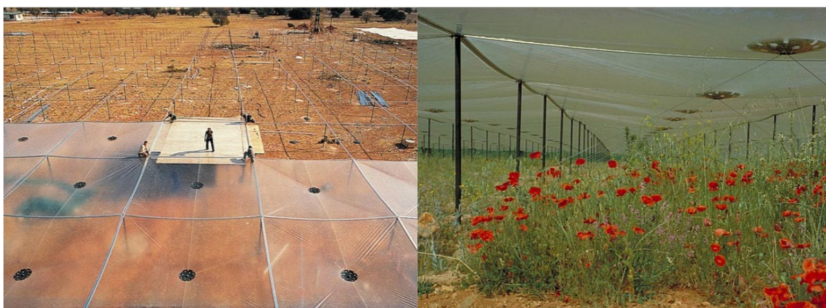
Kolektor: Vlevo montáž kolektoru (PVC fólie), vpravo vnitřní prostor kolektoru s vegetací
