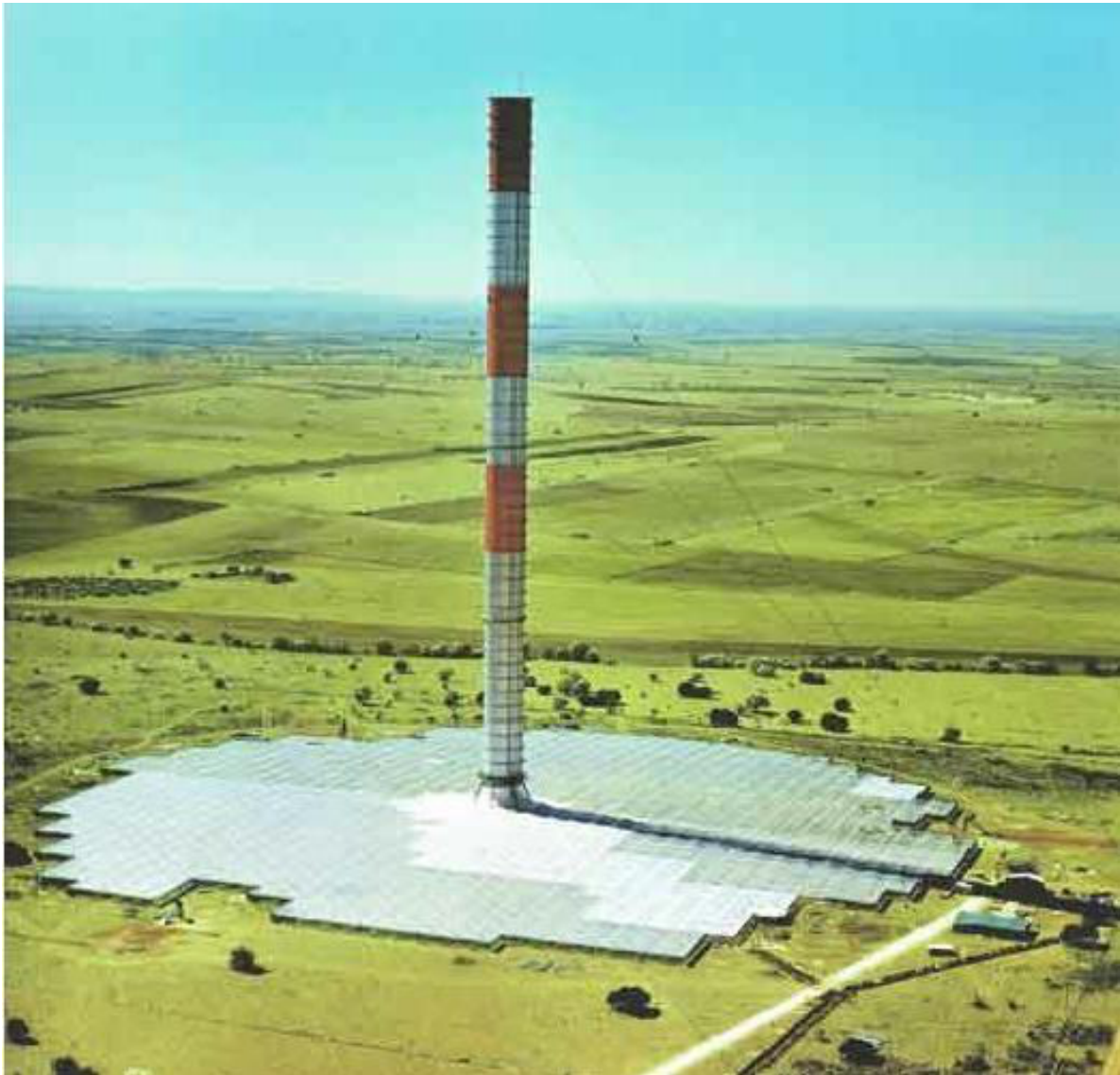
Solární komínová elektrárna v Manzanares, Schlaich & Bergemann 1982
