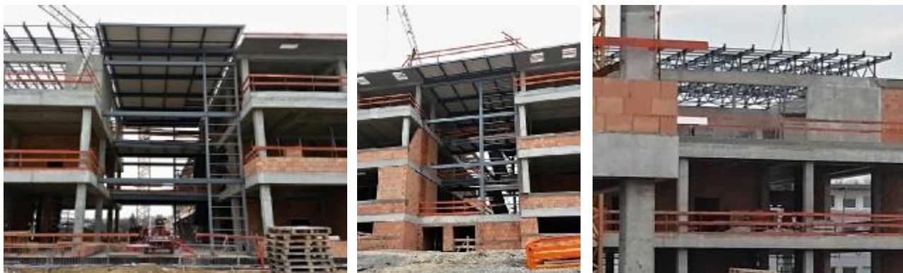
Polyfunkční budova v Ostravě Bludovicích kombinuje železobetonový skelet s ocelovou kostrovou konstrukcí vloženého komunikačního krčku i s příhradovou ocelovou konstrukcí zastřešení.
