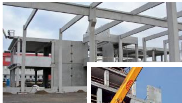
stěny nahrazující rámy (nahore a vpravo) stěna vložená do rámu (dole)
