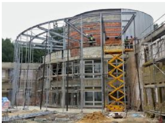
Polyfunkční budova v Ostravě Bludovicích kombinuje železobetonový skelet s ocelovou kostrovou konstrukcí vloženého komunikačního krčku i s příhradovou ocelovou konstrukcí zastřešení.
