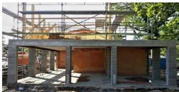
Kombinace zděné stěnové konstrukce se železobetonovým skeletem, na nich spočívá dřevěná kostrová nástavba.
