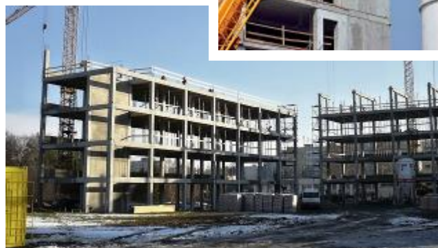
stěny nahrazující rámy (nahore a vpravo) stěna vložená do rámu (dole)
