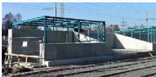
Kombinace zděné stěnové konstrukce se železobetonovým skeletem, na nich spočívá dřevěná kostrová nástavba.
