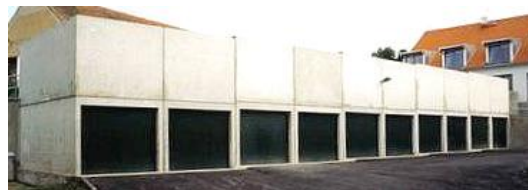
sloupcové, opačně orientované, uložení samonosných jednotek
