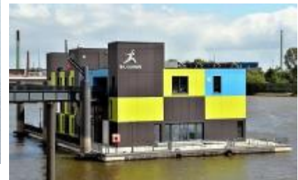
IBA Dock, výstavní a kancelářské prostory v Hamburku, Německo. Budova z ocelových prefabrikovaných modulů stojí na betonovém pontonu 25x43 m a plave na vodě. Její výška se mění spolu s hladinou vody (deně o 3,5metru).
