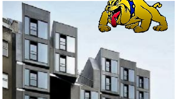
IBA Dock, výstavní a kancelářské prostory v Hamburku, Německo. Budova z ocelových prefabrikovaných modulů stojí na betonovém pontonu 25x43 m a plave na vodě. Její výška se mění spolu s hladinou vody (deně o 3,5metru).
