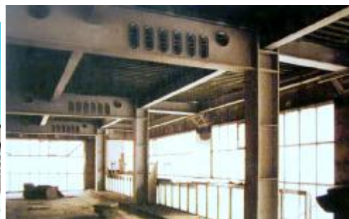
styk sloupu s průvlakem
