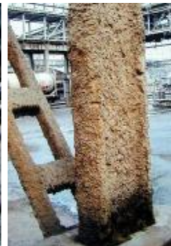
protipožární nástřik ocelových prvků
