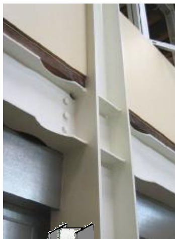
stýčník ocelového rámu (příklad řešení)
