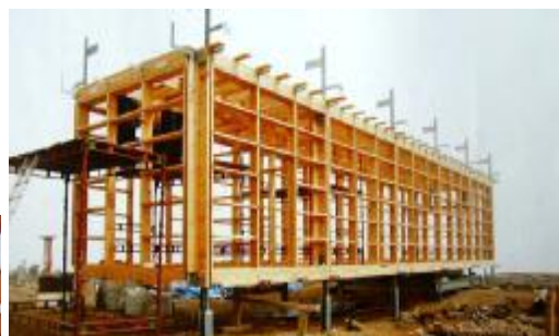
výstavba Nové poštovny Sněžka, ČR Hoffman, Rajniš Architekti 2007. Experiment Anežka; systém nosných dřevěných lešeňových ráků SSBS - proměnlivý 4-vrstvý
