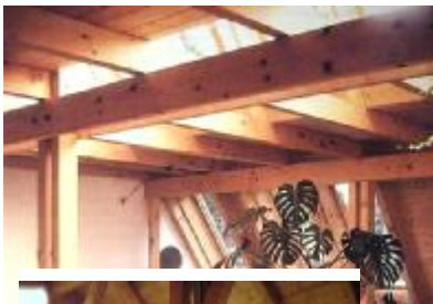
d) nosníky křížící se mimoběžně (ve 2 rovinách)
